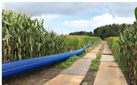
Links: Vor dem Rohreinzug werden die Rohre präzise vermessen und geprüft. Oben rechts: Transport der 20 m langen Druckrohre zum Verlegeort. Unten rechts: Die Renovierung mittels Spülbohrung umfasste eine Gesamtlänge von rund 740 m.
