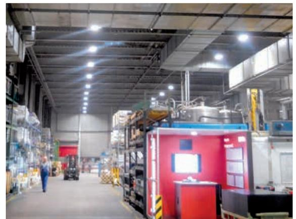
Ein nachhaltiges Beleuchtungskonzept, das auch noch 60 Prozent Energie gegenüber dem bisherigen spart: In zwei Etappen wurden im Werk II Platte am Hauptsitz in Kirn über 200 veraltete HQL-Leuchten ausgetauscht und mit LED-Lampen ersetzt. Das angenehme Licht trägt außerdem zur positiven Arbeitsatmosphäre bei.
