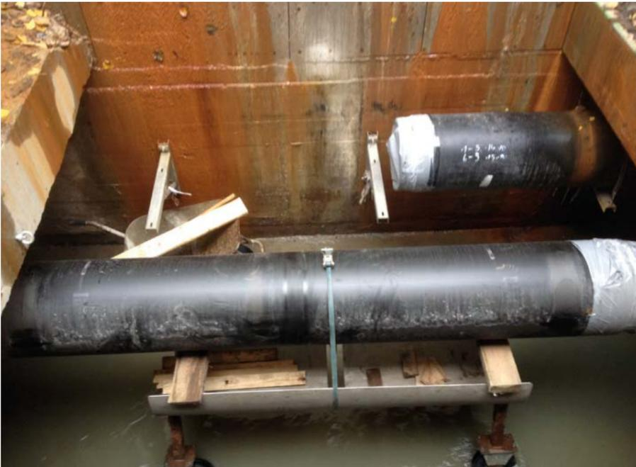
Transport der SIMOFUSE® Rohrmodule mit eigens dafür gebauten Rollwagen
