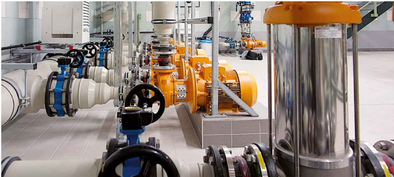
SIMONA® Rohrsysteme mit Pumpengruppe zur Wasserenthärtung in einer Wasseraufbereitungsanlage
