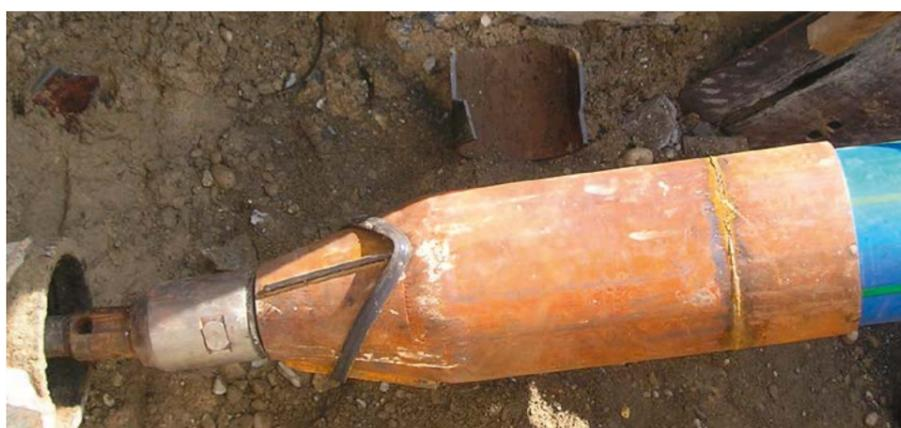
SIMONA<sup>®</sup> SPC RC-Line Trinkwasserrohr mit Berstkopf zum Einzug in das Altrrohr
