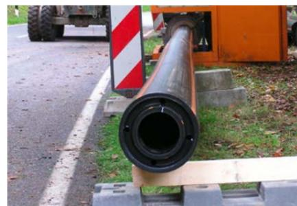
SIMONA® Doppelrohr zur Ableitung schadhafter Abwässer in Trinkwasserschutz-zonen
