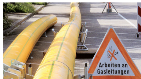
Svařence potrubí připravené na pokládku
