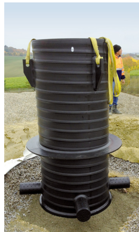
Skládkový odplynovací filtr SIMONA při montáži
