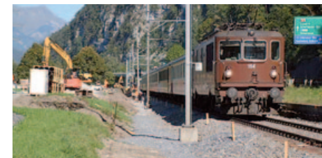
Příprava staveniště a skladiště trubek vedle železniční tratě za provozu
