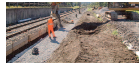
Řádná instalace do vsakovacího příkopu
