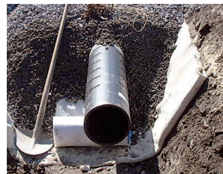
Obložení štěrkového lože filtru geotextilií
