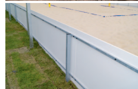
Nahoře: příprava na instalaci mantinelů Dole: nainstalované mantinely
