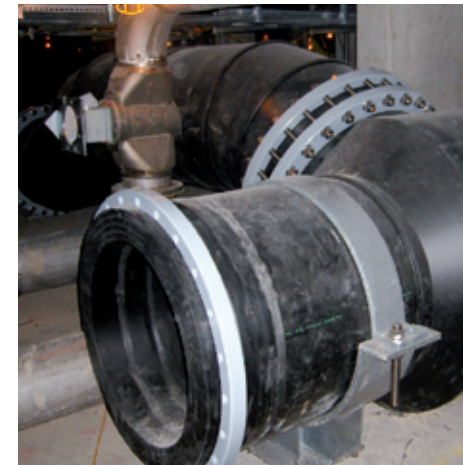
Svařená potrubí z PE 100 o průměru 900 mm SDR 17 vč. zesíleného T-kusu PN 10
