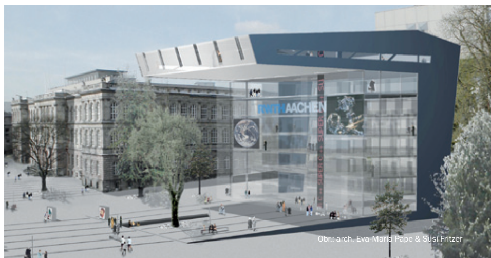
SIMONA® PP-H Alpha Plus® Geotherm pro hlubinný geotermální projekt univerzity RWTH Aachen
